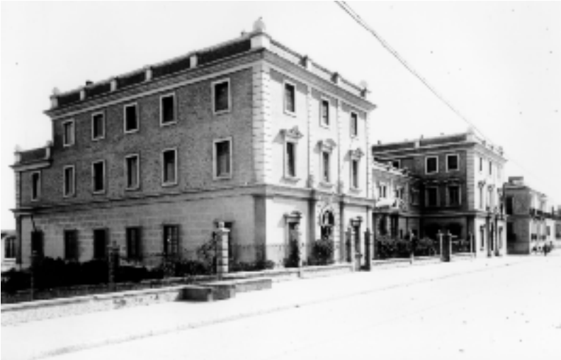
Figura 3. Edificio construido para la ubicación de una Oficina Hidrográfica Internacional y la Estación Biológica y donde una vez finalizado se instaló el Laboratorio Oceanográfico, el Acuario y el Museo. En este edificio que aún existe en el Paseo de la Farola en Málaga tiene sus dependencias la Comandancia de Marina.
