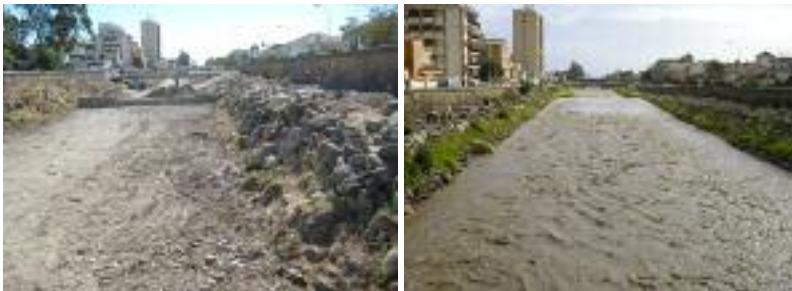
Figura 7. Durante el año 2010 se llevaron a cabo unas obras en el cauce del arroyo Jabonero (Málaga), con el fin de regular las fuertes avenidas que se estaban produciendo los últimos años y controlar así la desembocadura donde se ha construido un puente sobre el paseo marítimo. Este es un sistema más de retención de la carga sólida que transportan los cauces fluviales y que resulta vital para el sostenimiento del equilibrio dinámico de las playas. No son frecuentes las avenidas del arroyo pero sí son, por lo general, de carácter torrencial. (Izquierda) Construcción durante el verano de los muros de contención de las riadas. (Derecha) La primera avenida fuerte que registró el cauce en el mes de noviembre.
